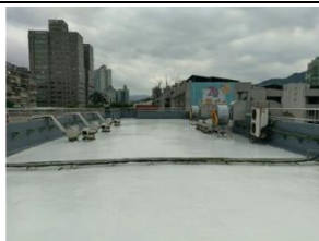
致知樓屋頂防水工程
