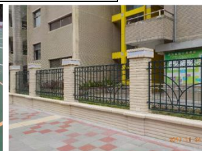
校園西側圍牆更新整建工程
