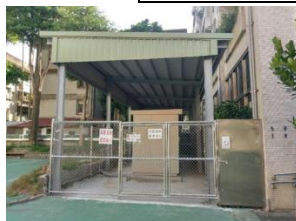
成功樓民生樓電力改善
